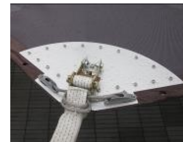
Système de fixation et de tension : Double plaque arc de cercle alu. ép. 3 mm, Ratchets, clamcleats et sangles de 50 mm.
